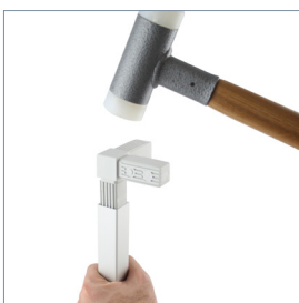
Einschlagen der Verbinder
