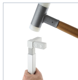
Einschlagen der Verbinder
